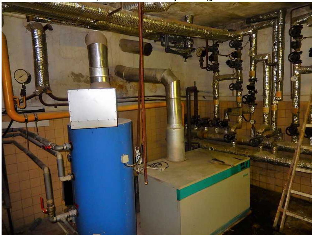
1.PP - kotelna na zemní plyn
